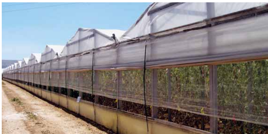
Una delle serre in legno/cemento-plastica dove sono state effettuate le prove
